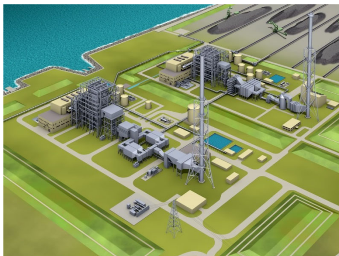
鹿島火力発電所2号機完成予想図（手前側） <（奥側）日本製鉄（株） 鹿島火力発電所1号機（稼働中）>
